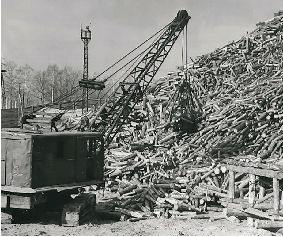
Впервые на страницах нашей газеты мы публикуем редкую фотографию из истории Балахнинского бумкомбината. На старой лесной бирже БЦБК с помощью кранов с грейферным захватом производилась разгрузка балансовых куч с древесным сырьем. Снимок сделан в 1957 году.
