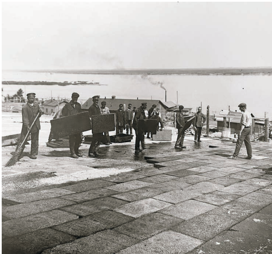
Укладка пробковой изоляции на крыше зала буммашин №1 и №2 в ходе строительства комбината. Июль 1927 года.
