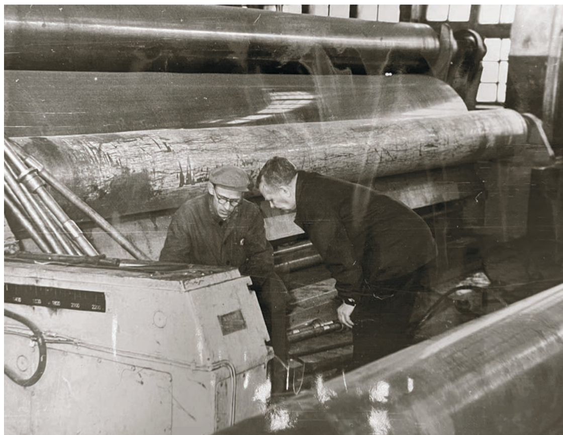
На этом фото запечатлены работники бумкомбината И.Д. Турупаев и П.И. Иванов за изучением конструкций конденсатоотводных труб сушильных цилиндров во время реконструкции бумагоделательной машины №2, 1965 год.
