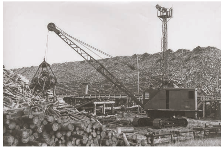
В шестидесятые годы на Балахнинском бумкомбинате усиленно внедрялась механизация производственных процессов. На снимке показана механическая разборка древесных куч с последующей механической подачей древесины в производство. Фото 1962 года
