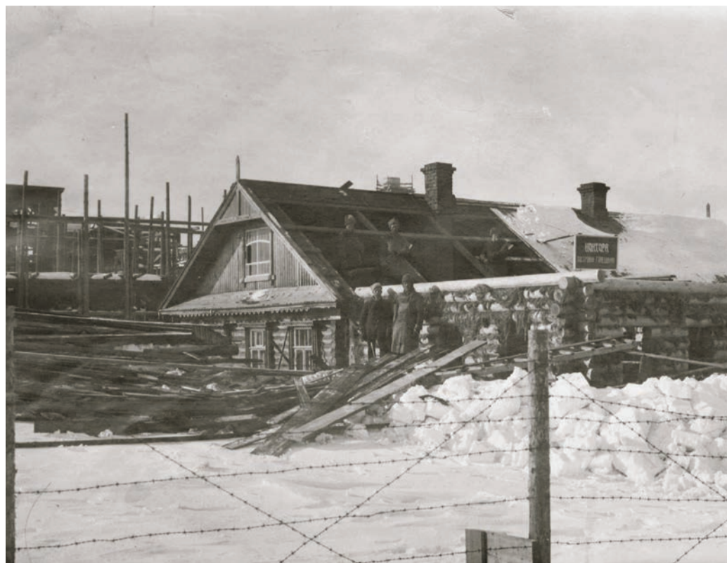
На этой старинной фотографии запечатлена частичка истории энергокомплекса (НиГРЭС) АО «Волга»: процесс строительства конторы главного здания станции (1920-е годы).
