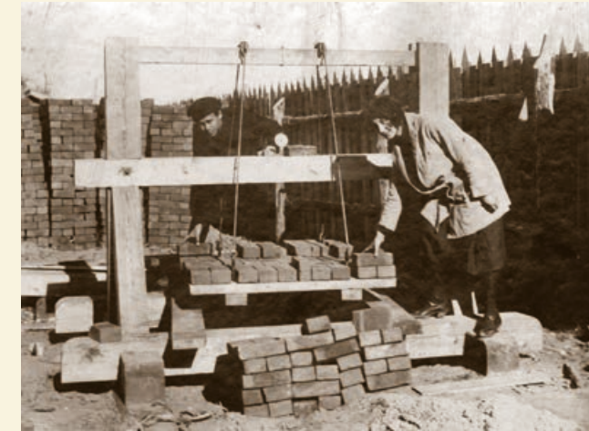
Первые кирпичи для строительства бумкомбината.
