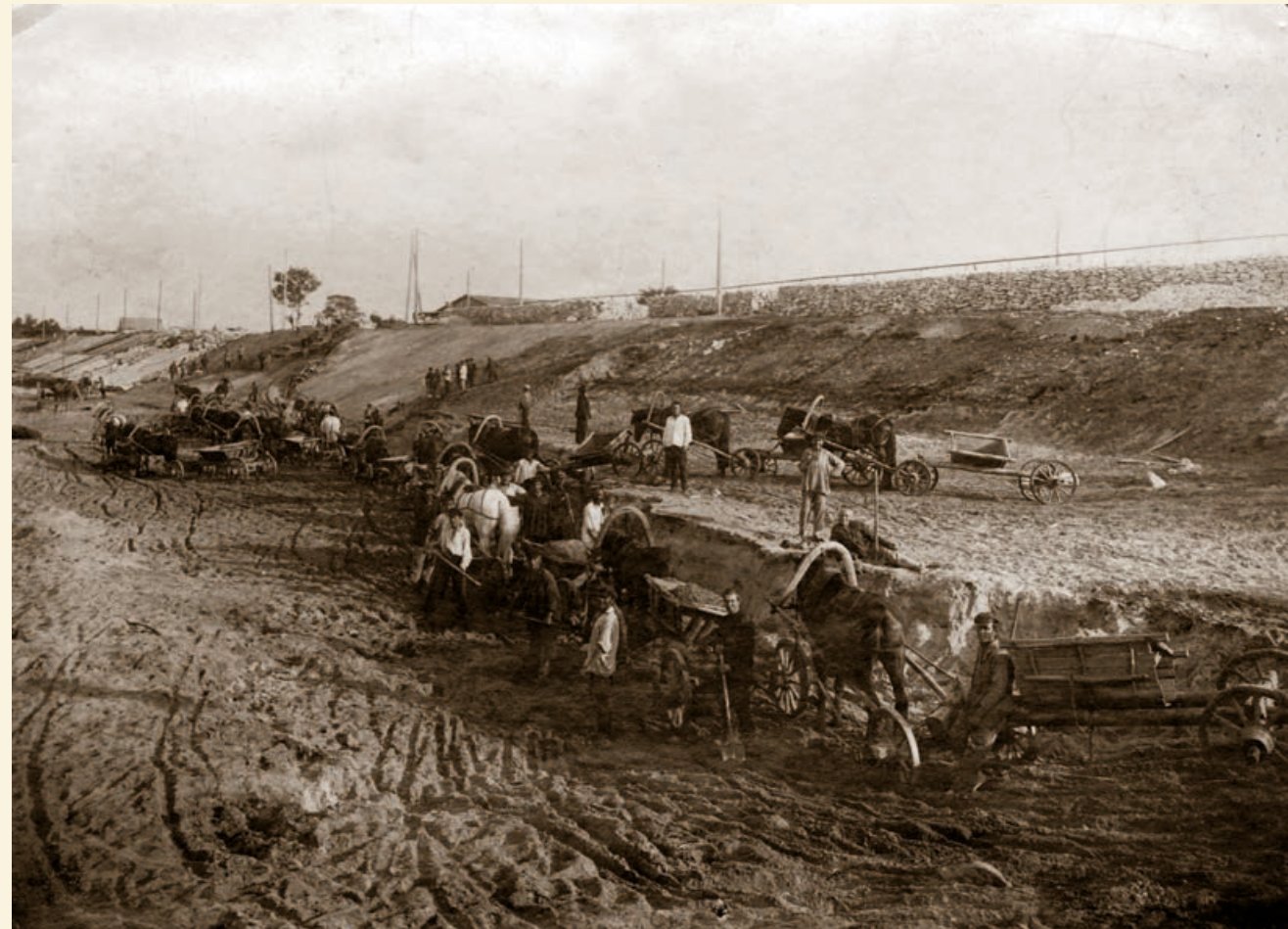
В 1925 году в поле возле деревни Курза началось строительство Балахнинского бумкомбината.
