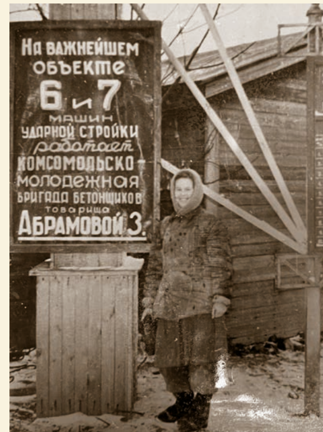
Во всех рабочих коллективах строителей и монтажников развернулось широкое социалистическое соревнование за досрочную сдачу производственных мощностей.
